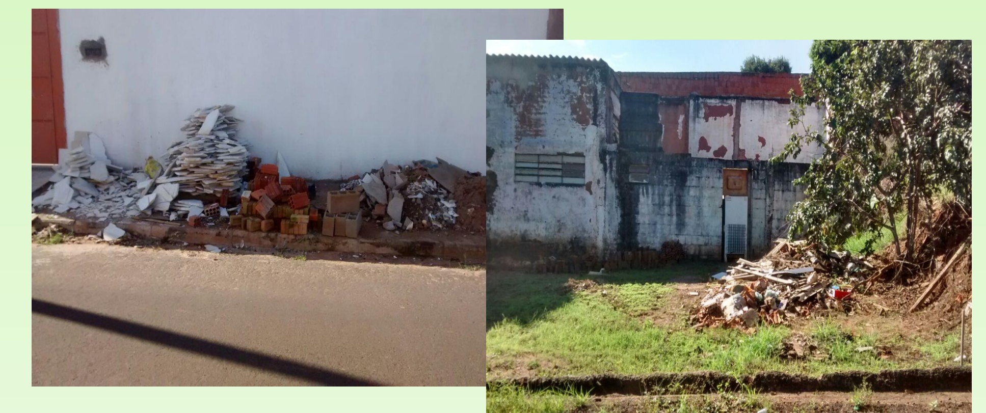
Entulhos da construção civil – Res. Santo Afonso e Vila Santa Rosa
