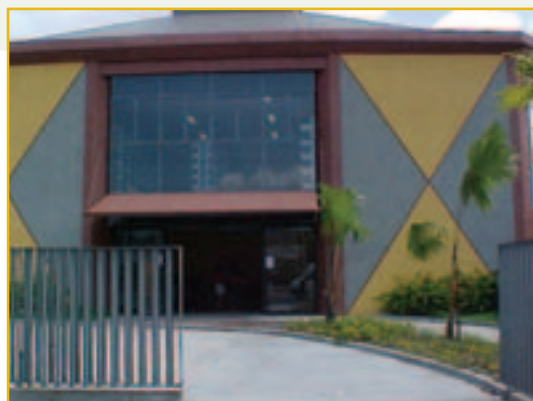
Visita realizada em 04/02/2003 com 100% de execução
