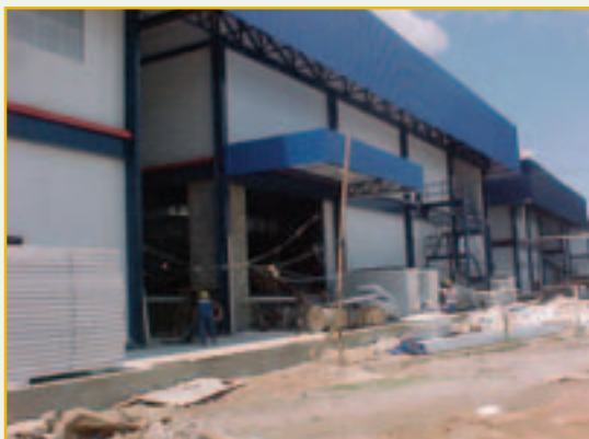
Visita realizada em 08/10/2002 com 50% de execução
