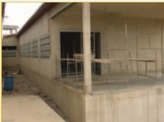
Visita realizada em 26/07/2002 com 73% de execução
