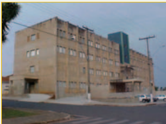
Visita realizada em 11/09/2002 com 65% de execução
