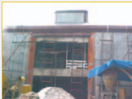
Visita realizada em 15/10/2002 com 60% de execução
