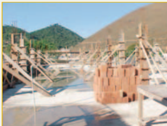
Visita realizada em 08/08/2002 com 46% de execução
