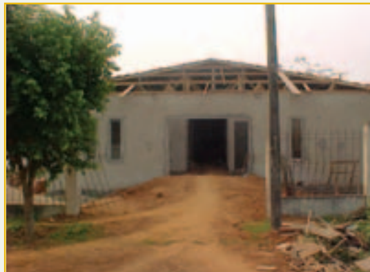
Visita realizada em 25/09/2002 com 20% de execução
