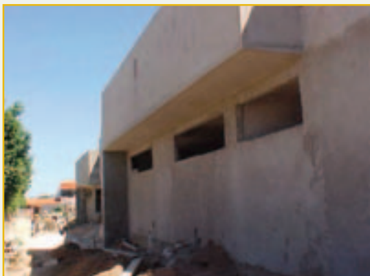
Visita realizada em 20/06/2002 com 59% de execução
