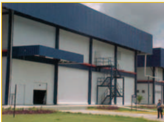
Visita realizada em 12/09/2003 com 100% de execução
