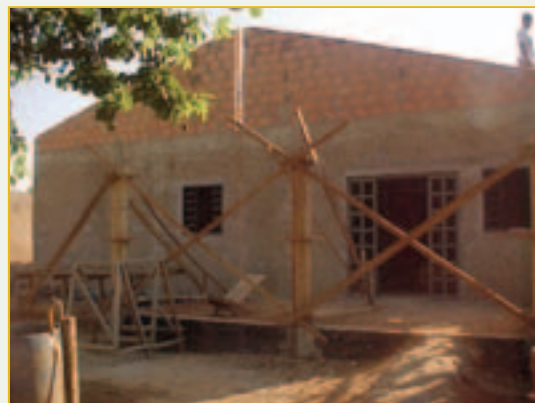
Visita realizada em 11/09/2002 com 35% de execução
