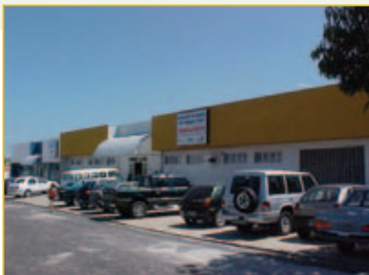
Visita realizada em 23/05/2003 com 100% de execução
