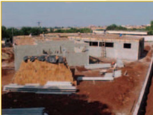
Visita realizada em 03/10/2002 com 15% de execução
