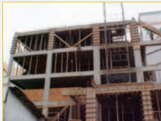
Visita realizada em 25/04/2002 com 8% de execução
