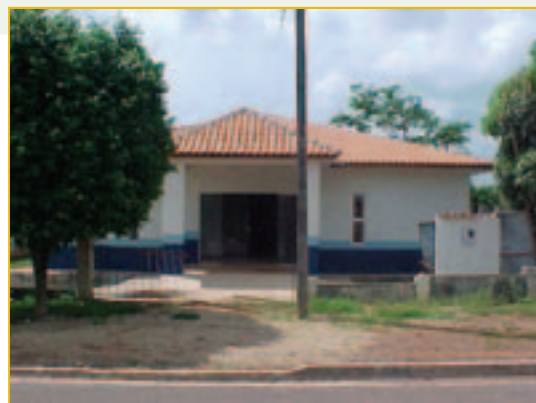
Visita realizada em 22/11/2003 com 100% de execução
