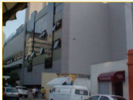
Visita realizada em 15/08/2003 com 98% de execução
