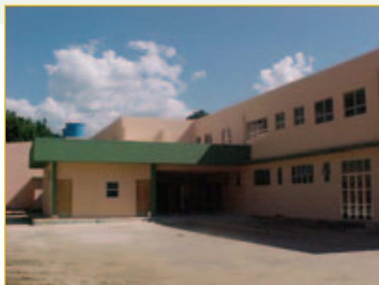
Visita realizada em 23/05/2003 com 99% de execução
