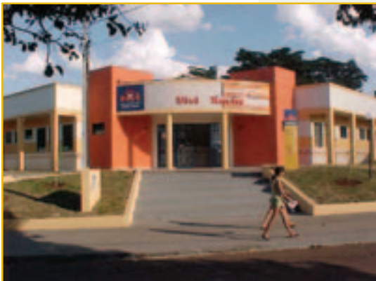
Visita realizada em 22/05/2003 com 100% de execução
