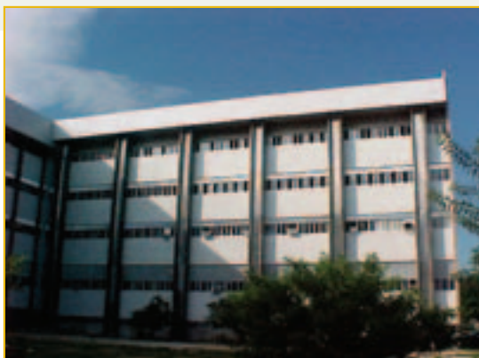
Visita realizada em 26/02/2003 com 100% de execução
