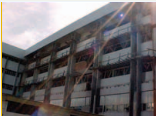
Visita realizada em 08/05/2002 com 38% de execução
