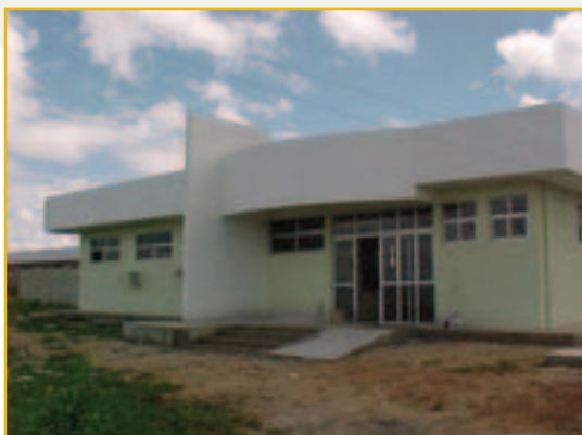
Visita realizada em 15/05/2003 com 87% de execução
