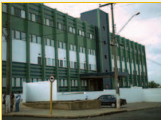
Visita realizada em 05/06/2003 com 80% de execução
