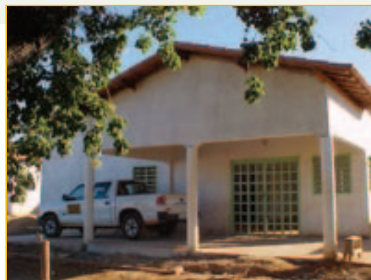
Visita realizada em 24/07/2003 com 74% de execução
