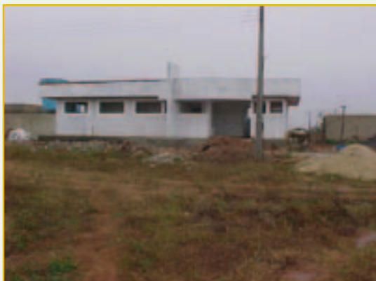
Visita realizada em 16/09/2002 com 60% de execução
