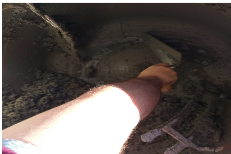
Figura 9: Raspagem do concreto preso
