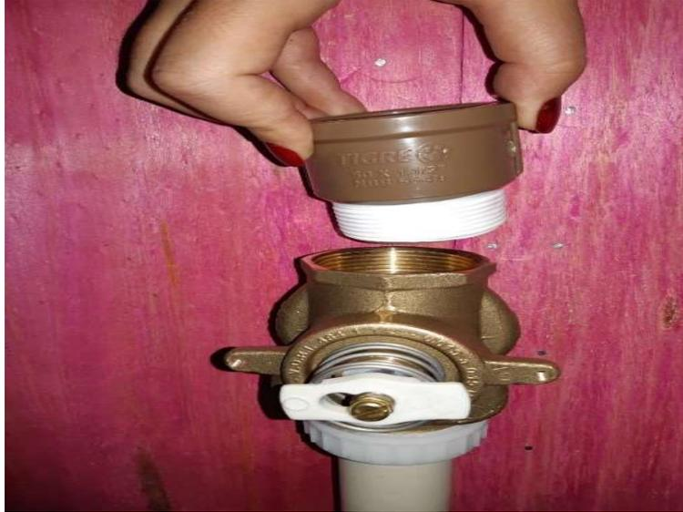
**Figura 12:** Válvula de descarga recebendo o adaptador (fonte: As autoras, 2020).
