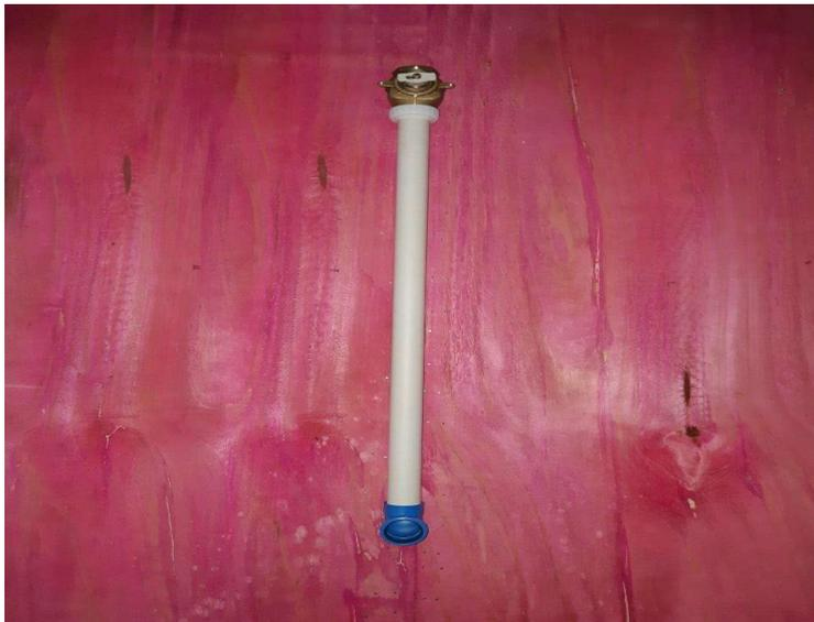
**Figura 11:** Válvula tubulação de descarga instalada, pronta para receber o vaso (fonte: As autoras, 2020).
