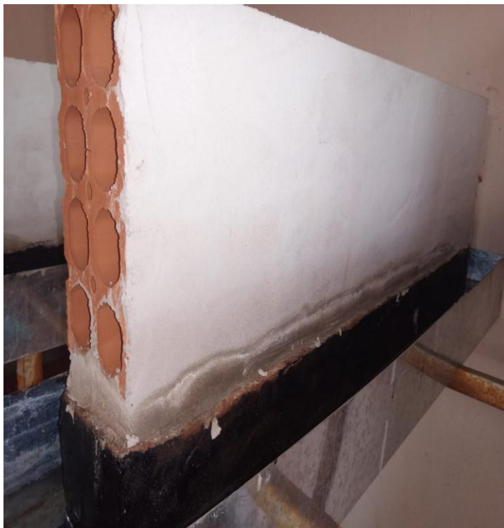
Figura 16 - Amostra 4, com o surgimento de manchas de umidade no 5º dia.
