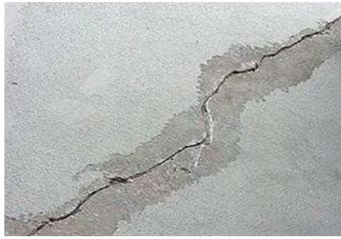
Figura 1. Fissura Geométrica. Fonte: Corsini (2010).
