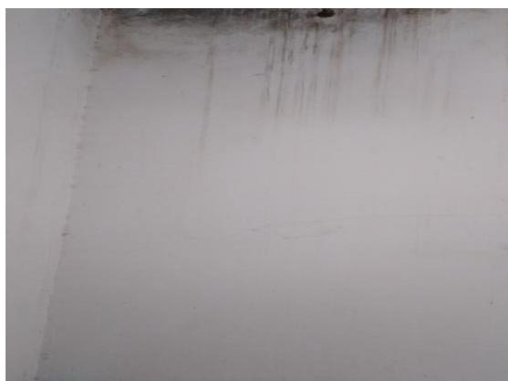
**Figura 10 - mofo em parede interna**
