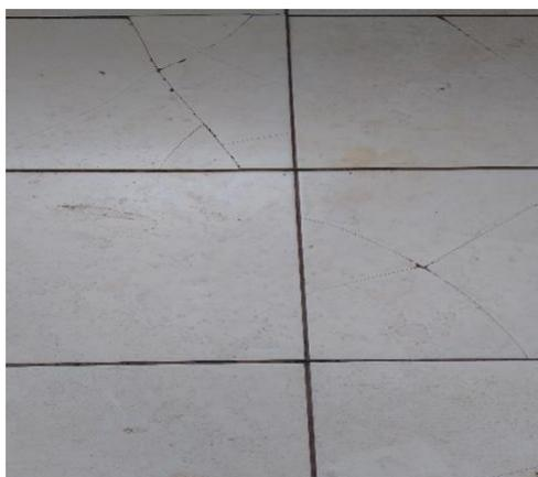
Figura 14 - trincas no piso cerâmico
