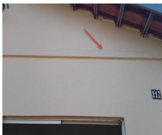
Figura 7 – fissura horizontal próxima ao teto
