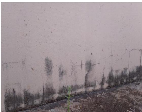
**Figura 8 - mofo em parede externa**
