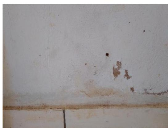
**Figura 11 - descamação de pintura no rodapé de parede interna**
