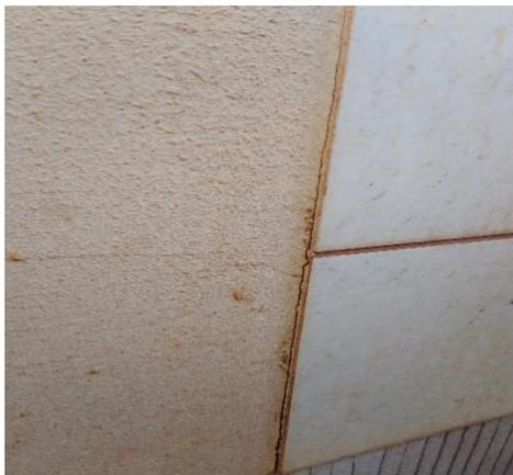
Figura 15 - deslocamento de revestimento cerâmico
