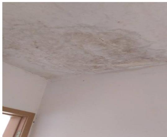
**Figura 9 – mancha de infiltração na laje**
