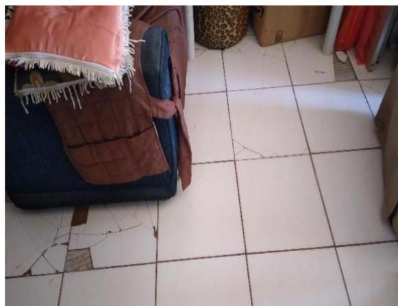
Figura 13 – descolamento e trincas piso cerâmico
