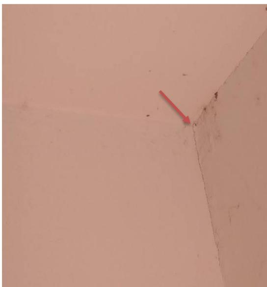
Figura 4 – trincas na junção laje/viga
