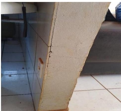
Figura 12 – descolamento de revestimento cerâmico
