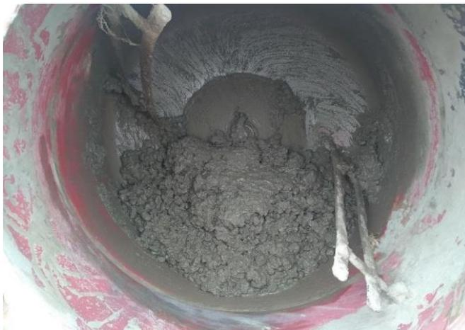
**Figura 2.** Mistura dos componentes do concreto na betoneira. Fonte: Autora, 2022.
