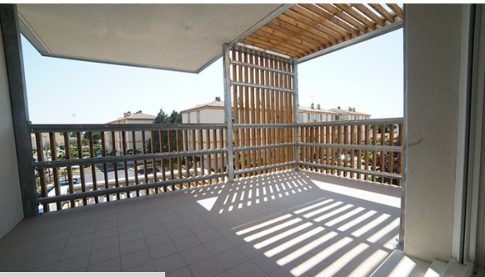
Interior da sacada Fonte: Archdaily
