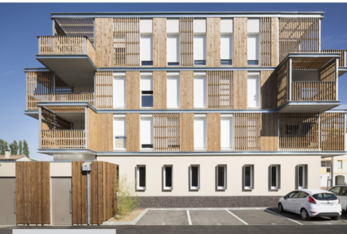
Fachada Oeste Fonte: Archdaily
